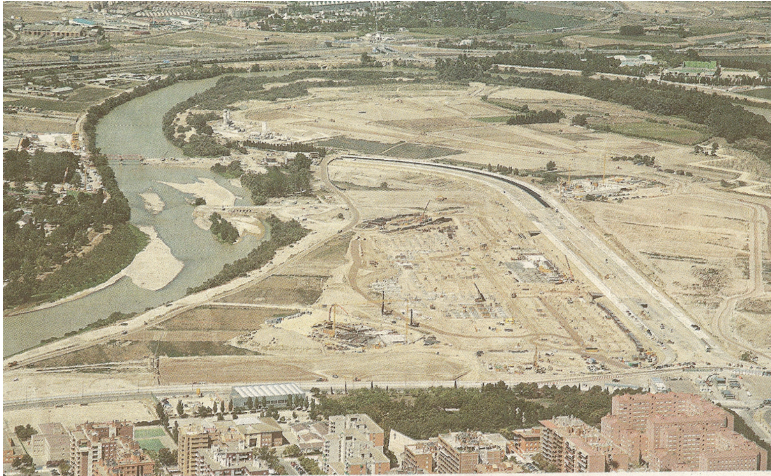
Julio 2006 La cimentación de los pabellones estaba avanzada, al igual que la urbanización de la ronda. EXPOAGUA/ENVUELO
