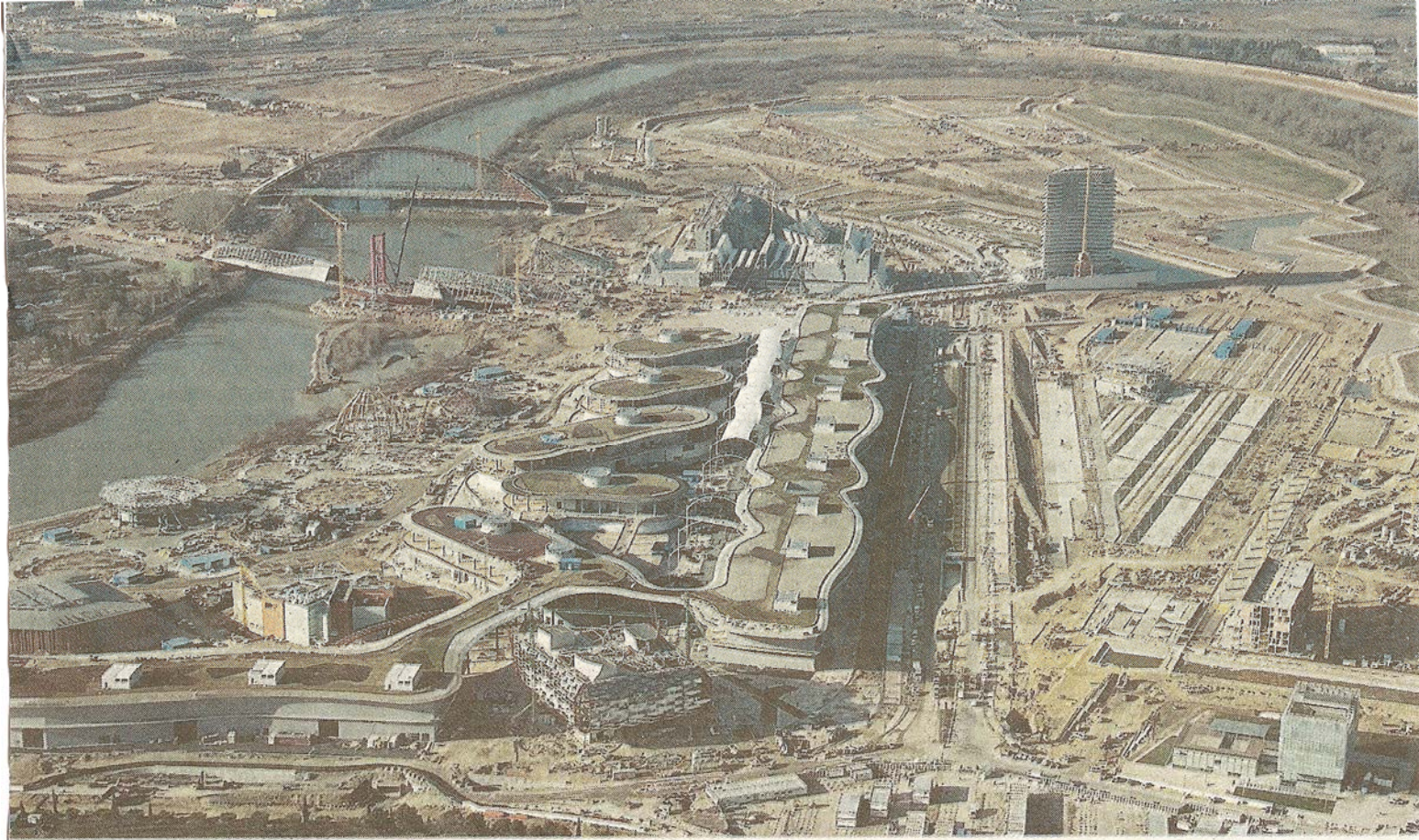
Enero 2008 El recinto está casi acabado y pendiente de vestir los edificios con los contenidos previstos. EXPOAGUA/ENVUELO
