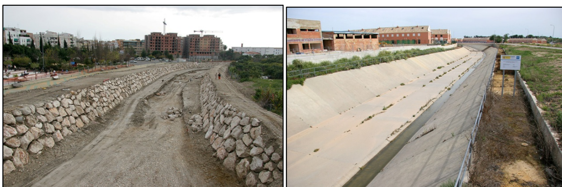
Fotos 3 y 4. Tramos de encauzados con escollera (izquierda) y hormigón (derecha) (c) Tony Herrera.
