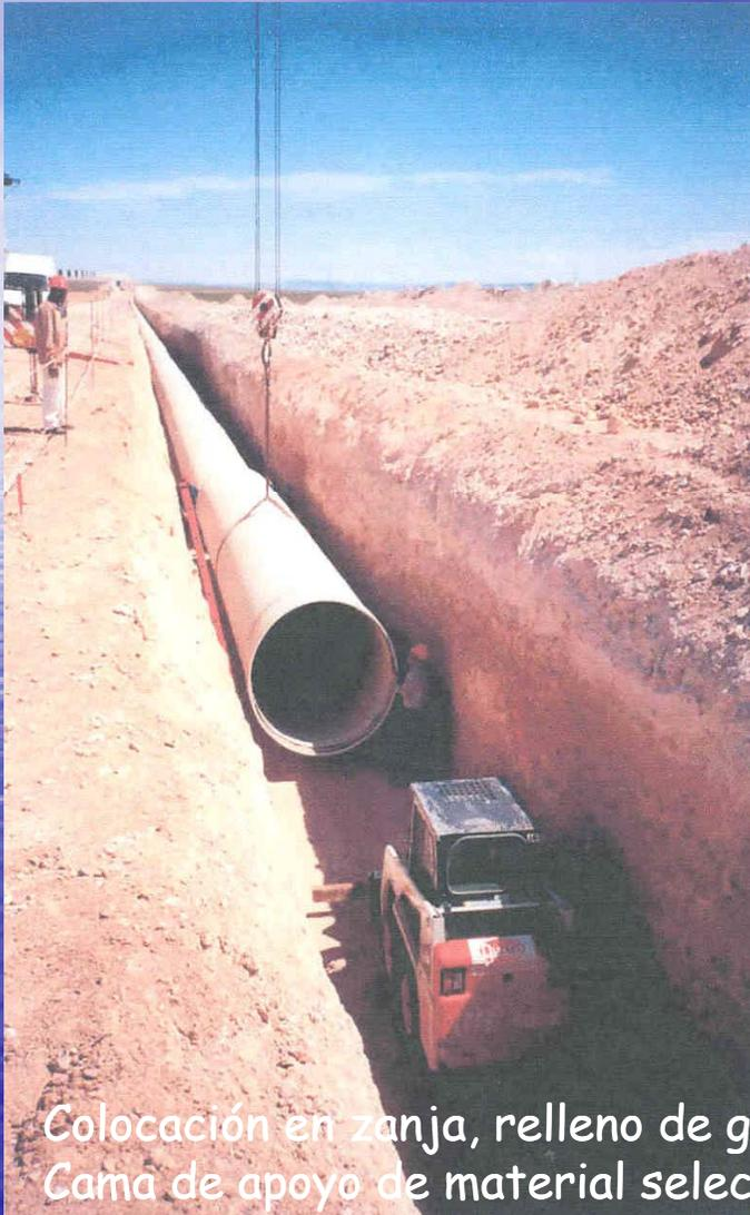
Colocación en zanja, relleno de grava natural 6/20 mm.
