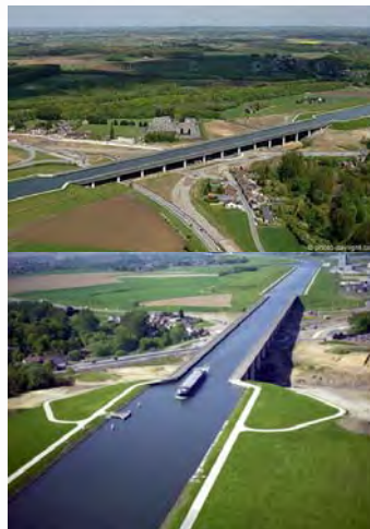
Obra en el sur de Bélgica.
